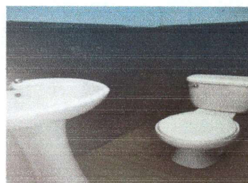
Foto 6: Finalizado el trabajo de la sustitución de inodoros que incluye llave de abasto contra llave y tanque y sustitución de piso en sanitarios.
