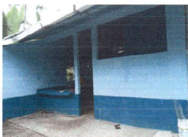
Foto 3: Finalizado el trabajo de la reparación de cocina e instalación de lamina aluzinc.
