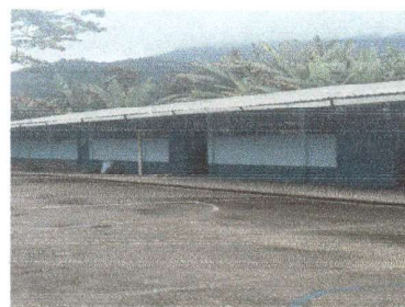
Foto 4: Finalizado el trabajo de la sustitución de canales en toda la escuela y sustitución de canales PVC.
